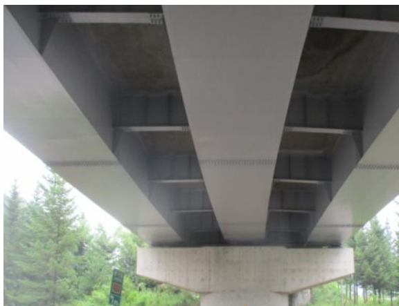
바닥판, 거더, 가로보
