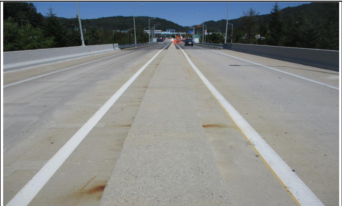
교량 상부 전경
